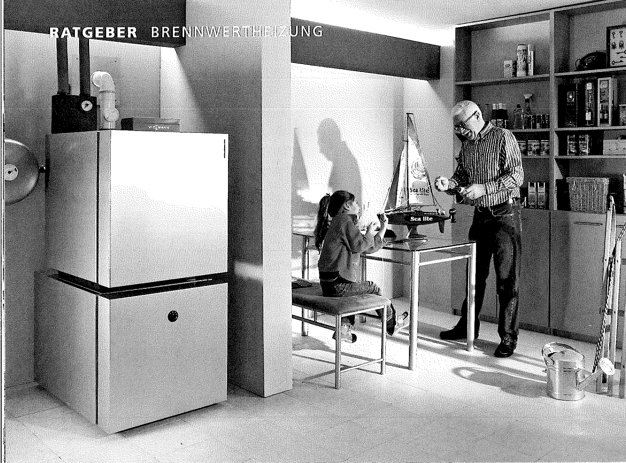
Eine neue Öl-Brennwertheizung arbeitet energiesparend und kommt bei Bedarf mit wenig Platz aus – hier liegt der Warmwasserspeicher unter dem Kessel. Viessmann
